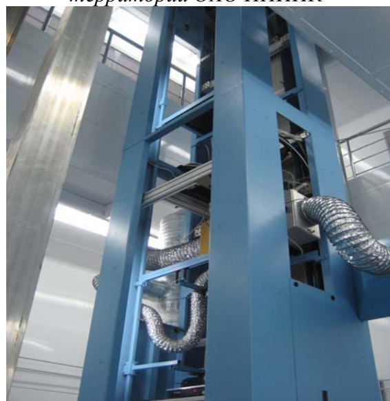
Шахта установки для вытяжки оптоволокна
